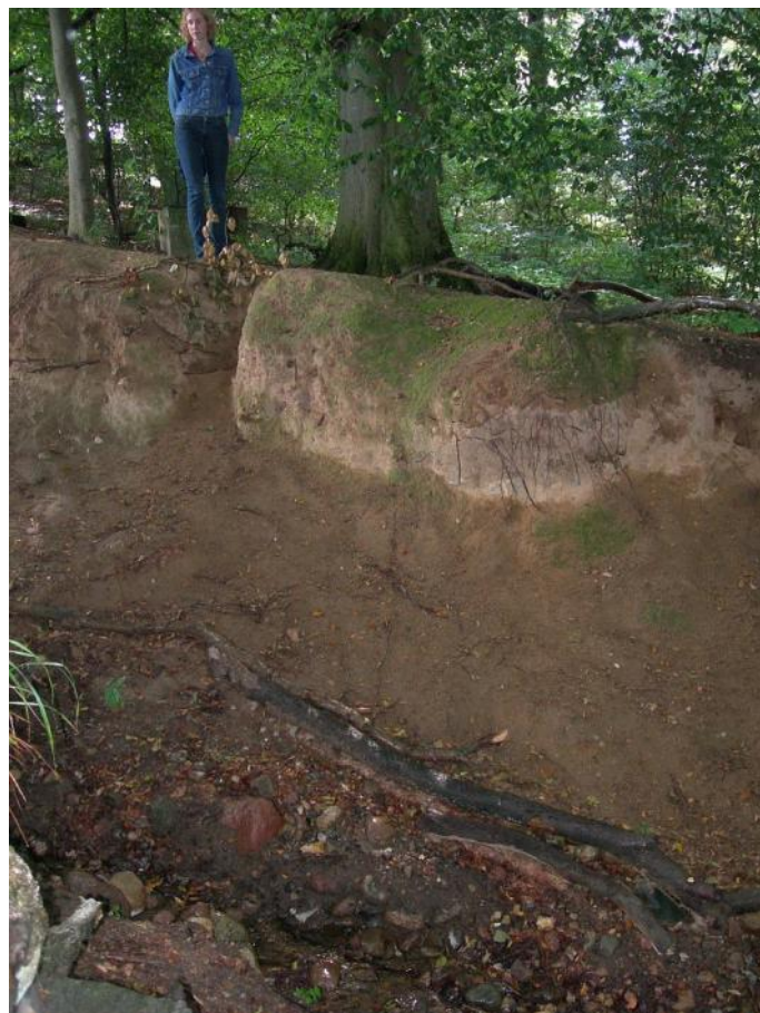
Fotos 5 und 6: Erosionsrinne am Ostufer des Suhrer Sees.
