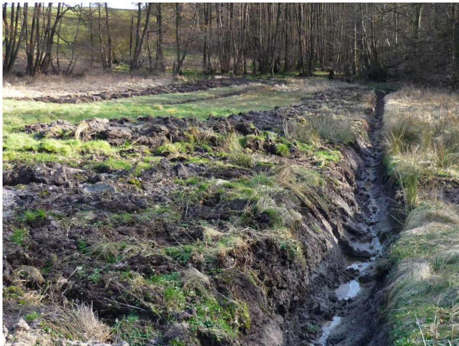
Foto 8: Hangentwässerung, Kreis Stormarn, 2010.
